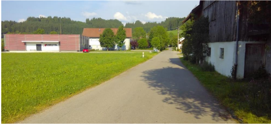
Straßenbestand von Westen aus betrachtet
